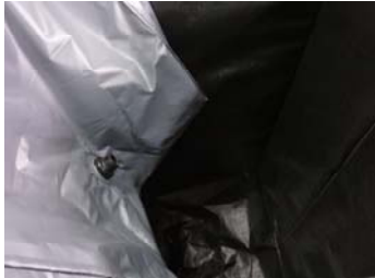
Inliner mit dem Auslaß Nach unten einlegen
